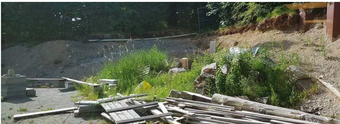
Slik så det ut før arbeidet begynte.
