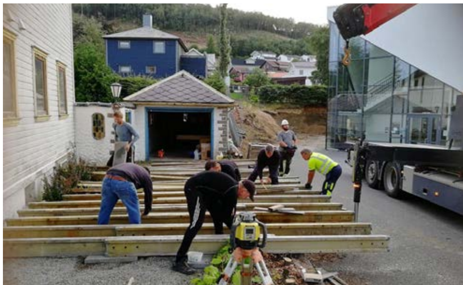
Dugnadsgjengen i god gang. Plassen her brukes til å produsere betongelement som skal heises på plass etter hvert. Foto: Terje Michaelsen
